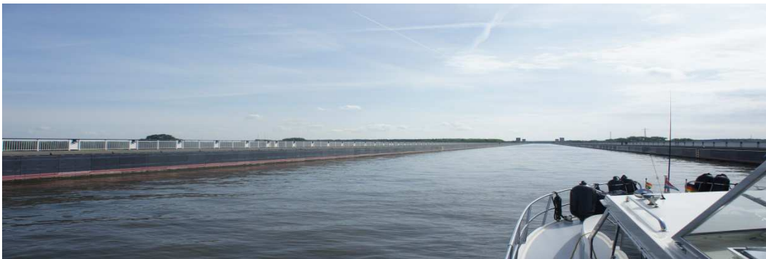
Aequadukt über die Elbe Nähe Magdeburg
